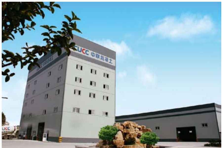
青岛中联混凝土搅拌站外景
