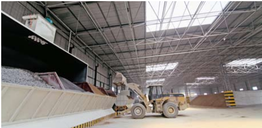
全封闭式环保混凝土搅拌站内景
